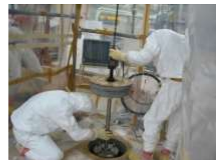
高線量下でのポンプ点検
