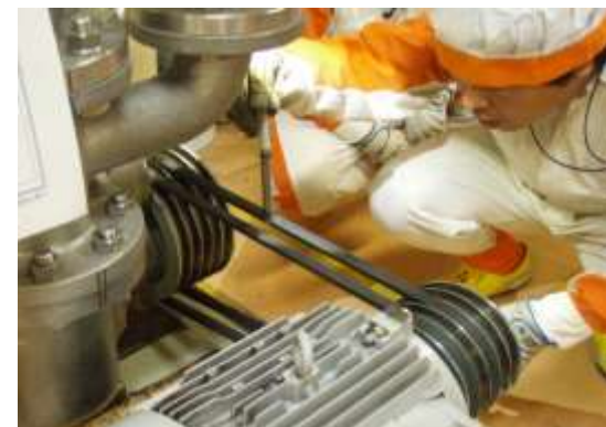
④点検保守(排風機のベルト交換)
