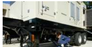
緊急電源ケーブルの接続作業 (移動式発電機)
