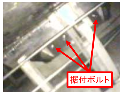
③据付ボルトの観察 (予備貯槽)
