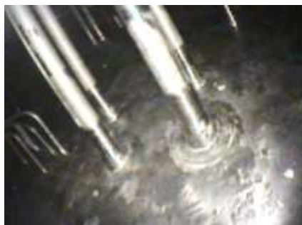
②貯槽上部配管の観察 (予備貯槽)
